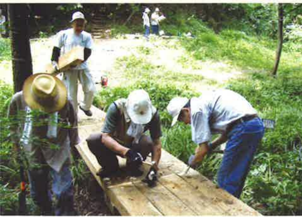
国分寺崖線や河川の自然を未来へ残す ● 成城にある国分寺崖線の樹林地で、湧水の小川に架かる橋の架け替え作業。
