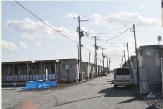
8世帯×31棟＝248世帯の応急仮設住宅
