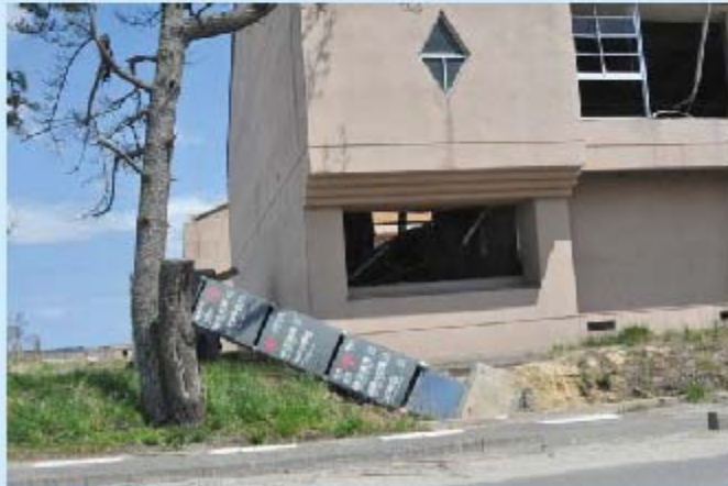
小学校の体育館。
