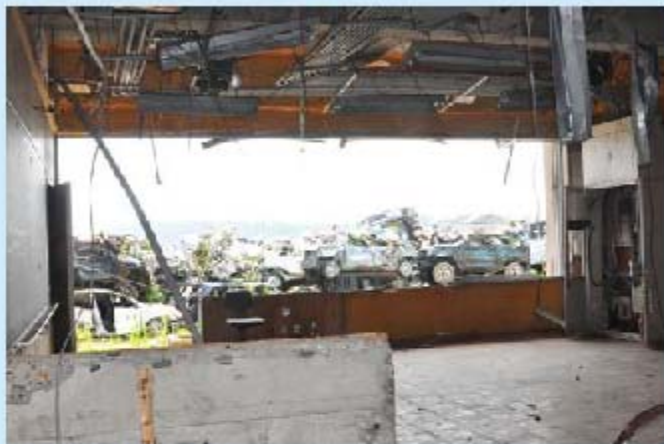
山元町中浜小学校内部。
