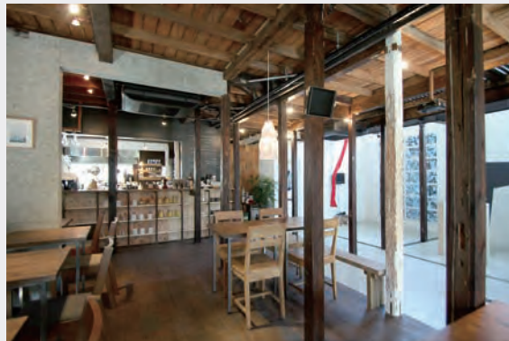
【HAGISO】 築60年木造アパートを店舗(カフェ) + ギャラリー + 事務所スペースへ
