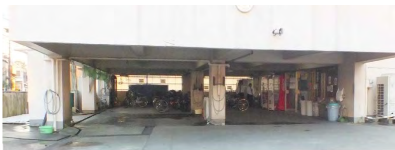
図 4-3-3-2. 建物 1 階車庫全景
