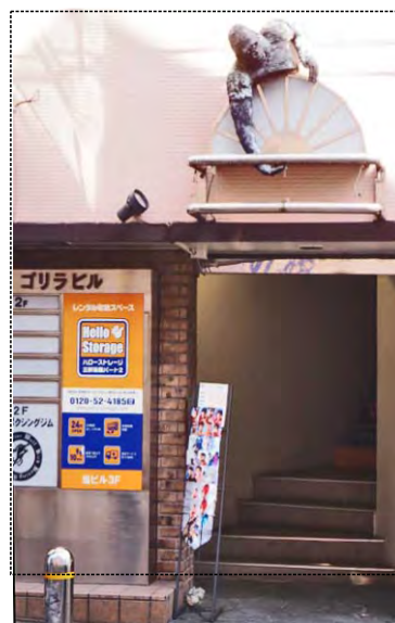
ゴリラビルの出入り口
