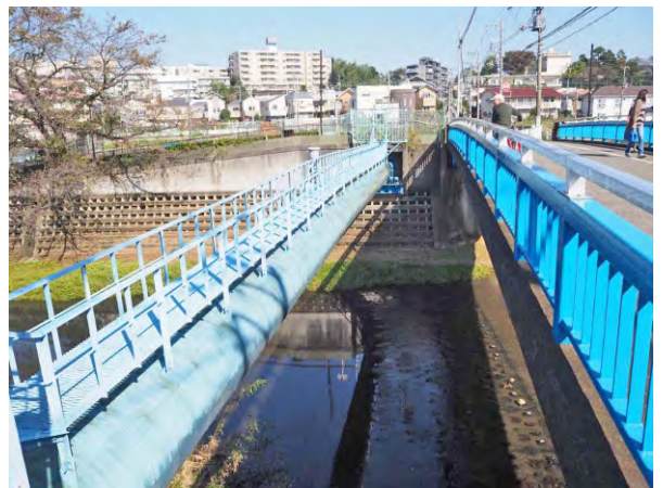
水道橋 右側が道路用 左側が水管用
