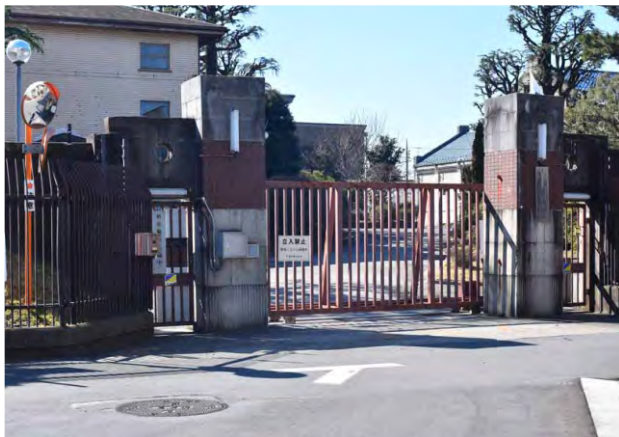
砦下浄水所正門
