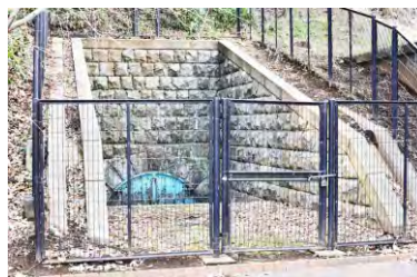
隧道出口（給水所側）
