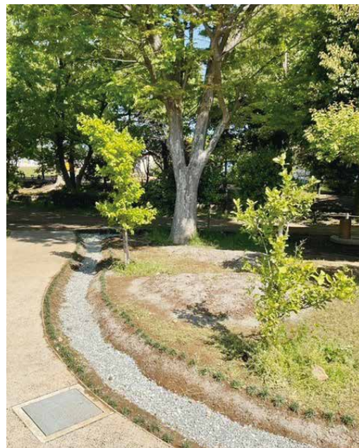
▲ワークショップで施工した里山農園のバイオスウェル（生物低湿地、緑溝）型雨庭
