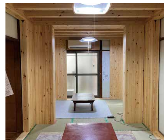
木質耐震シェルターを設置した部屋の様子
