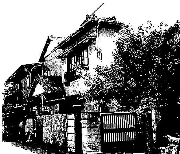
共同建て替え(建て替え前)
